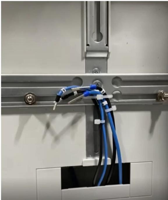
Im Schaltgerätfeld ist die Zuleitung der Spannungsversorgung mit Aderendhülsen versehen, welche nicht isoliert sind. Dies führt im Falle der Inbetriebnahme des Netzanschlusses dazu, dass die Aderendhülsen unter Spannung stehen. Dies stellt sowohl für unsere Mitarbeiter als auch für weitere Personen ein erhebliches Sicherheitsrisiko dar.
