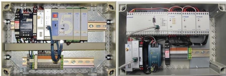
Bild 2: Eingesetzte Fernwirkanlagen bei EWE NETZ GmbH
