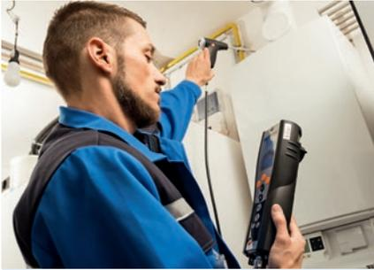
Bei jedem Gerät wird eine Sichtprüfung (Istzustandsanalyse) und Abgasmessung durchgeführt.
