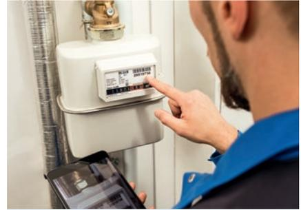
Die Leitungsanlage wird in Augenschein genommen, olfaktorisch auf Gasgeruch geprüft und der Gaszählerstand erfasst.
