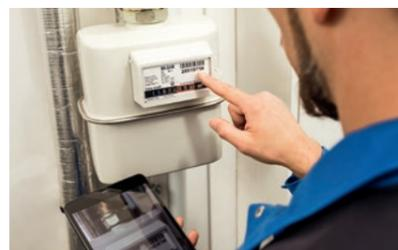
Die Leitungsanlage wird in Augenschein genommen, olfaktorisch auf Gasgeruch geprüft und der Gaszählerstand erfasst.
